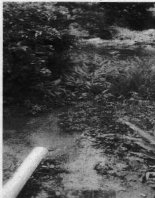
Imagen 6: se observa el tubo de drenaje del lavado a metro y medio de la fuente hídrica
