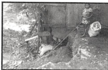
Figura 17. Erosión hídrica, hundimiento del terreno donde está construida la vivienda de la comunidad Dai Kirisia.
