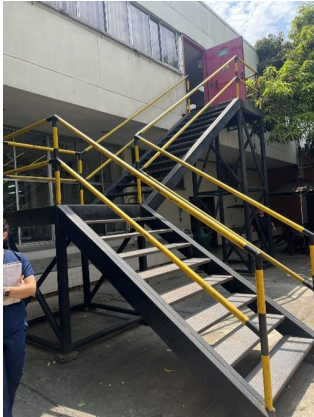
Foto 25. Escalera salida de Emergencia
