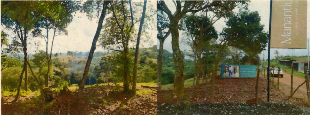
fotos 5 y 6. evidencia de la intervención de árboles (cortes de tocones) y la adecuación, previa explanación, a la orilla de la vía Jamundí-La estrella
