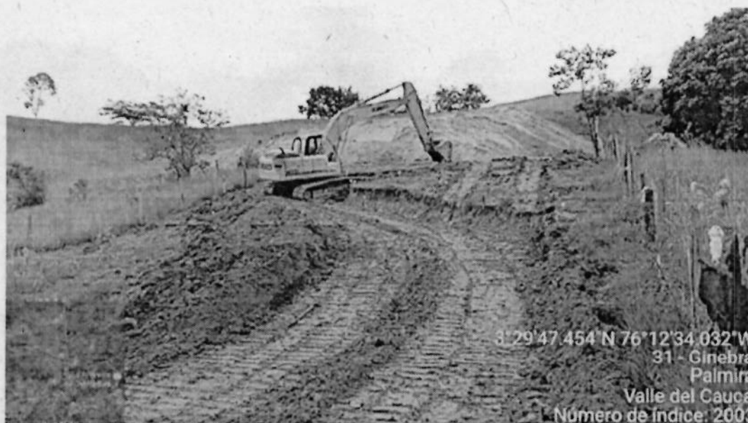
Fotografía 1: Retroexcavadora abriendo la vía interna en el predio.
