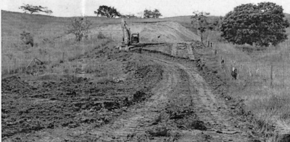
Fotografía 3: Maquinaria amarilla estacionada sin funcionar.
