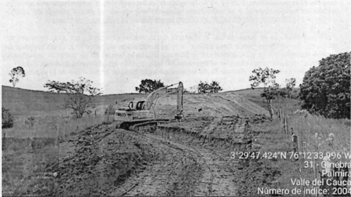
Fotografía 2: Retroexcavadora sacando tierra de la apertura de la vía interna del predio.
