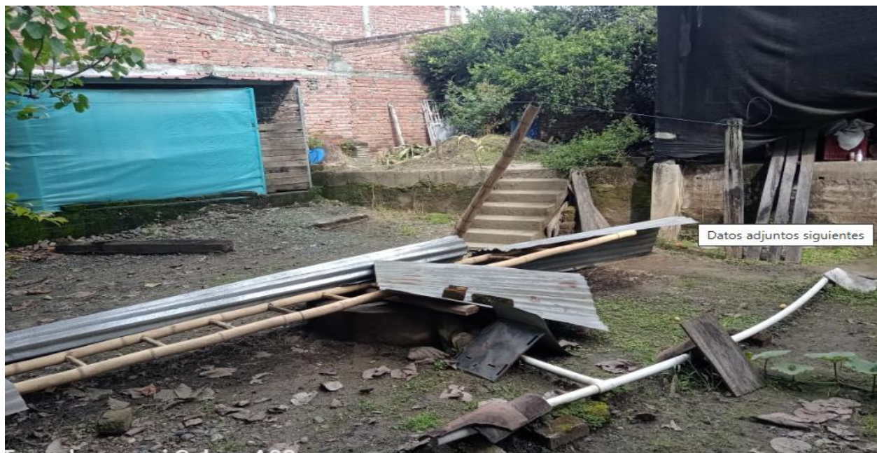
Foto No. 2. Ubicación del aljibe, con instalación eléctrica y tubería de conducción.
