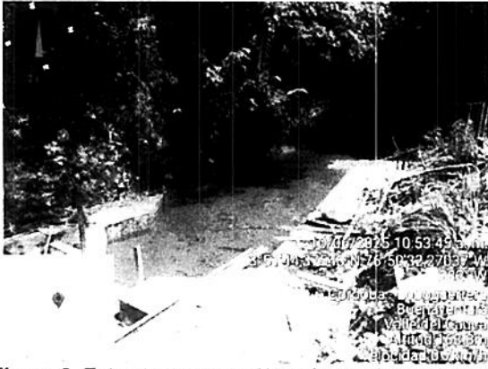
Figura 3. Estructuras en gavión sobre ambos márgenes de la quebrada Los Álamos. En la imagen se evidencia ocupación de cauce de la quebrada. Fuente: CVC (2025).
