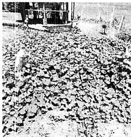
Foto N° 3. Área de ubicación de presumible caja receptora de las aguas residuales
