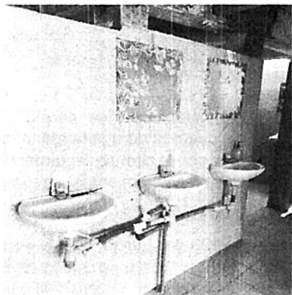
Foto N° 2. Área común con unidades sanitarias
