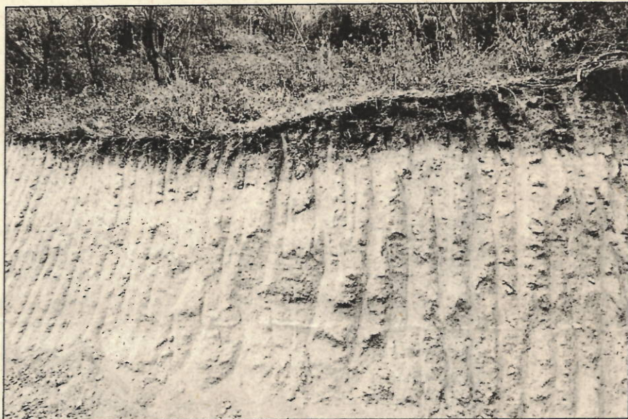
Foto 3. Corte de talud
