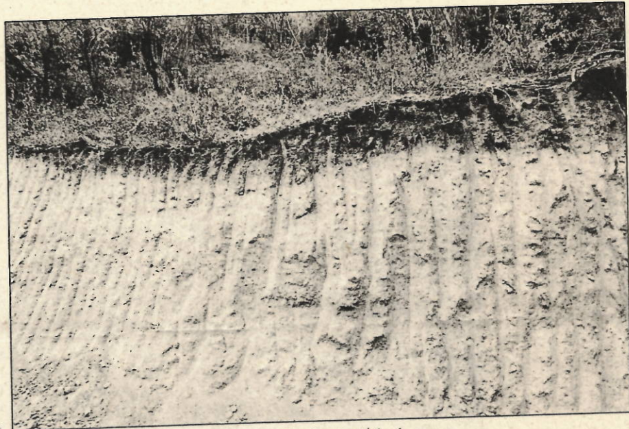
Foto 3. Corte de talud
