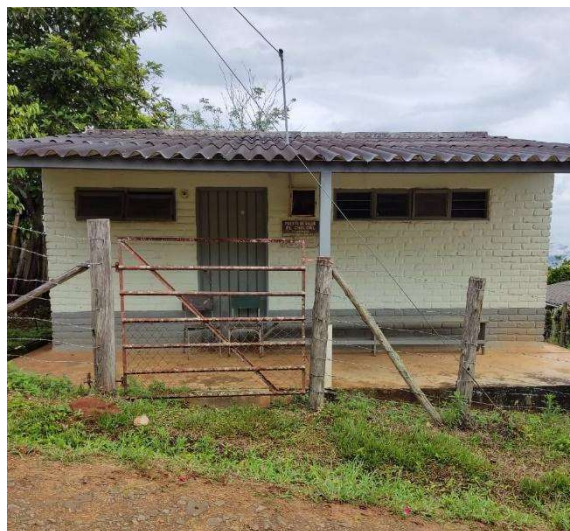
Figura 30. Puesto de salud en desuso de la Vereda.
