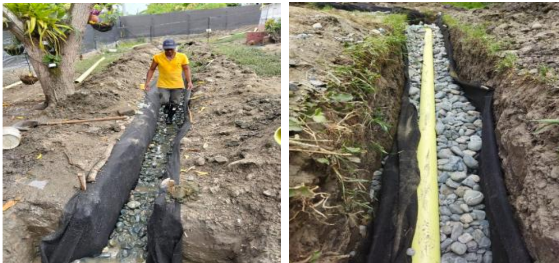
Foto: Campo de infiltración del predio La Gloria
