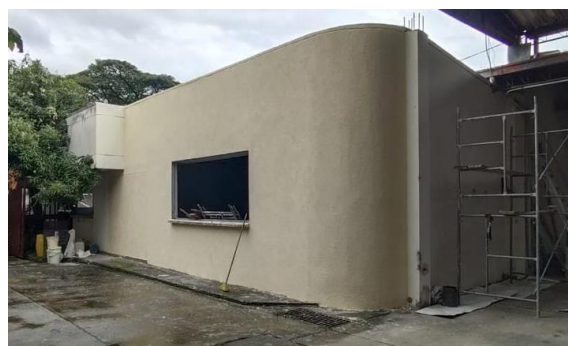
Foto 187. Obras de adecuación Centro Cultural CVC, (detalle exterior). Archivo CVC 2025.
