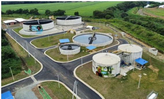
Foto 112. Construcción de la PTAR de la cabecera municipal de Jamundí. Archivo CVC, 2025.
