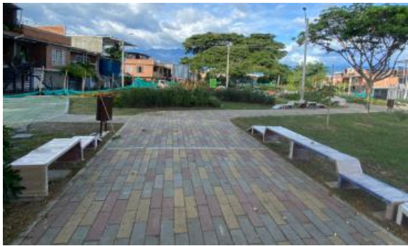
Foto 150. Adecuación de sendero. Archivo CVC, 2025
