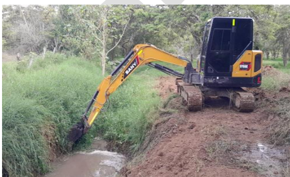
Foto 146. Descolmatación Quebrada Cauquita – Municipio Roldanillo. Archivo CVC, 2025
