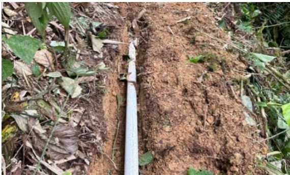
Foto 126. Excavación de zanjas e instalación de tuberías en el proceso de optimización del sistema de abastecimiento de agua para la Comunidad Indígena Join Jeb en el municipio de Buenaventura. Archivo CVC, 2025.
