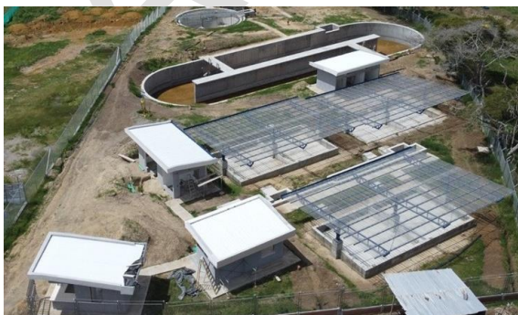
Foto 114. Construcción de la PTAR de la cabecera municipal de El Dovio. Archivo CVC, 2025.
