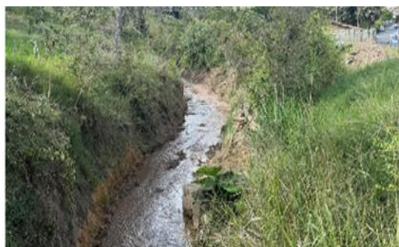
Foto 147. Descolmatación río El Dovio – Municipio de El Dovio. Archivo CVC, 2025
