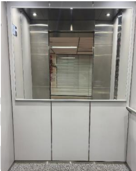
Foto 189. Modernización de los dos ascensores del edificio principal de la CVC, (detalle interior). Archivo CVC 2025.
