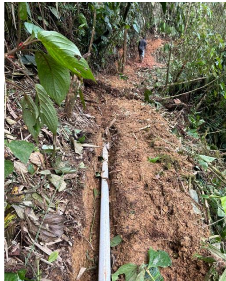
Foto 122. Excavación de zanjas e instalación de tuberías. Optimización del sistema de abastecimiento de agua para la Comunidad Indígena Dachi Drua Mundi de Ansermanuevo. Archivo CVC, 2025
