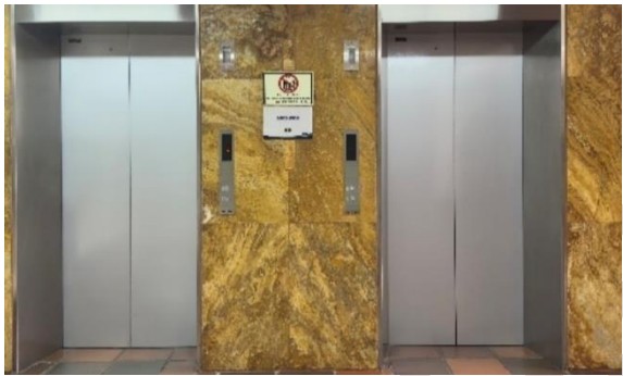
Foto 190. Modernización de los dos ascensores del edificio principal de la CVC, (detalle exterior). Archivo CVC 2025.
