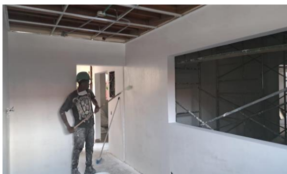
Foto 186. Obras de adecuación Centro Cultural CVC, (detalle interior). Archivo CVC 2025.
