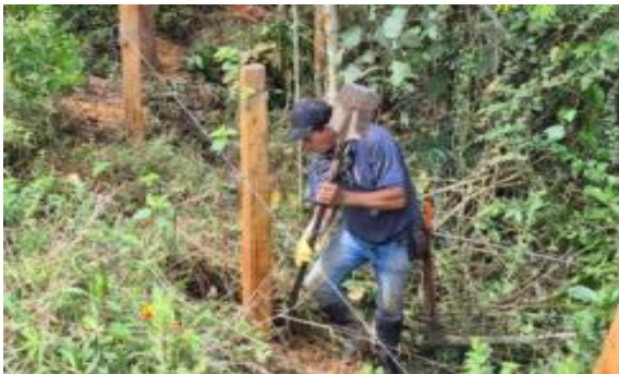
Foto 124. Restauración Ecológica. Estrategia ARA. Aislamiento de Protección. Cuenca Pescador. Predio El Porvenir. Archivo CVC 2025
