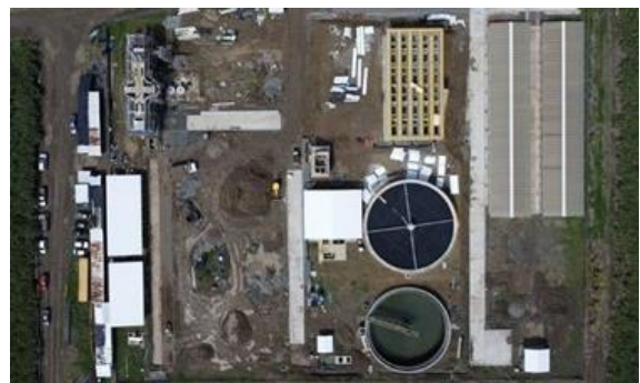
Foto 115. Construcción de la PTAR de la cabecera municipal de Zarzal. Archivo CVC, 2025.
