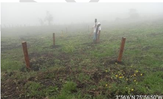
Foto 61. Instalación de la posteadura para aislamiento. Archivo CVC, 2025
