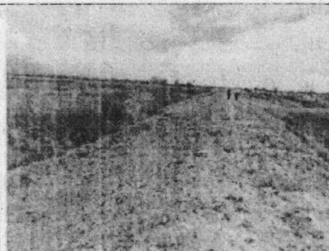
Imagen 8. Estado actual del dique coordenada 3
