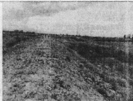
Imagen 9. Estado actual del dique coordenada 3
