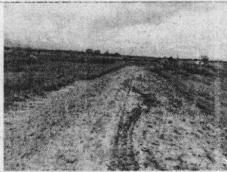
Imagen 11. Estado actual del dique coordenada 4
