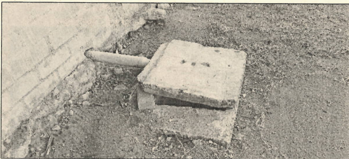
Foto 11. Vista de cajas recolectoras donde llegan las aguas de lavados de establos.
