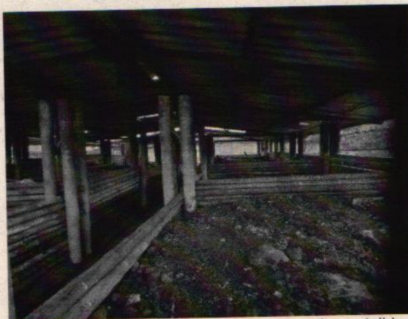
Foto 4 y 5. Panorámica de la compostera de mortalidad
