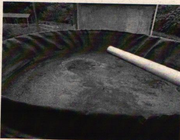
Foto 10 y 11. Panorámica tanque estercolero en adecuación
