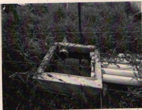
Foto 16 y 17. Panorámica caja de unión de caudales y quemador de gases en adecuación
