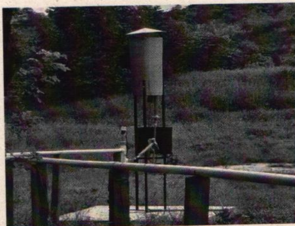
Foto 16 y 17. Panorámica caja de unión de caudales y quemador de gases en adecuación
