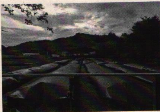
Foto 14 y 15. Panorámica biodigestores en adecuación
