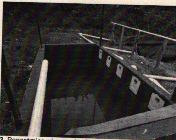
Foto 12 y 13. Panorámica cámara de distribución de caudales en adecuación
