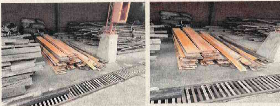
Fotos 5 y 6. Proceso de descarga del material en las instalaciones auxiliares en Cali
