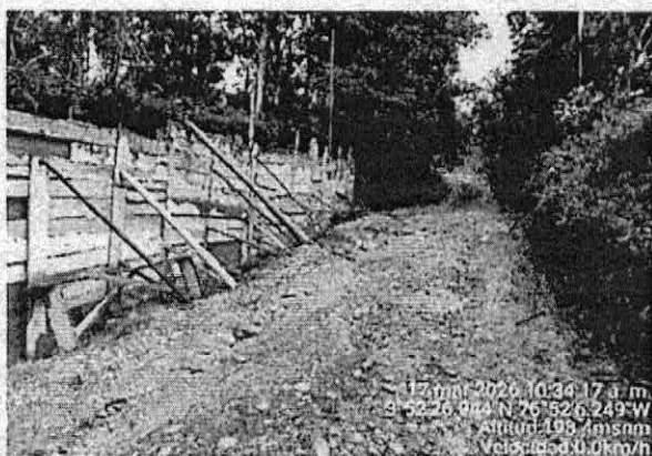
Foto 31. Sitio construcción muro en ferro concreto.
