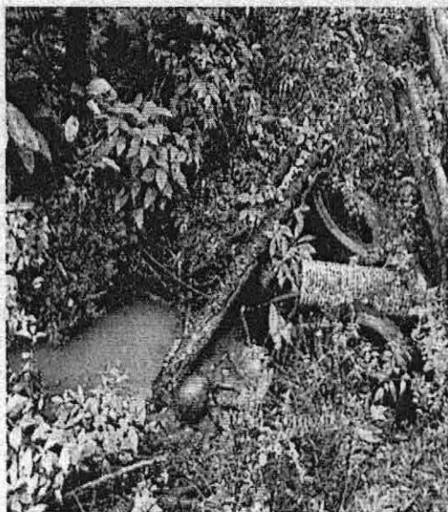
Foto 7. Sumidero margen derecho.
