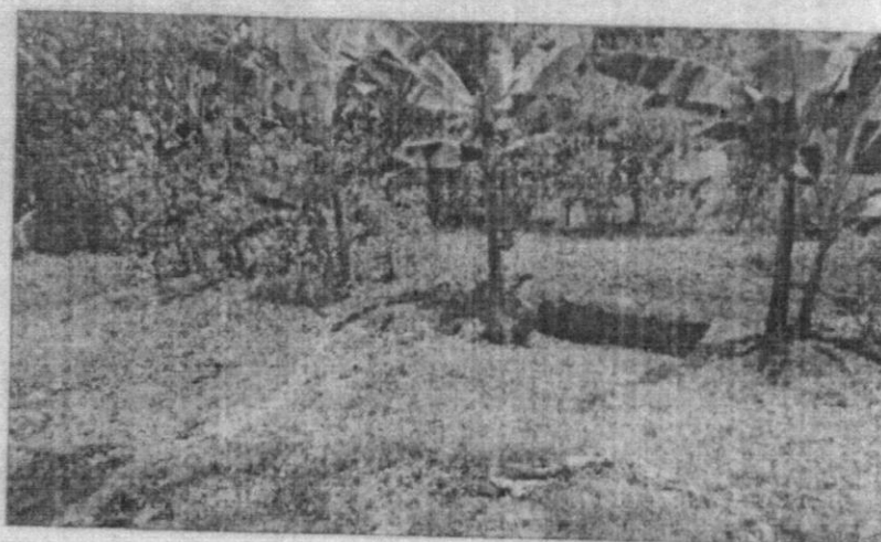
Foto No. 3. Excavación para la construcción de un estercolero
