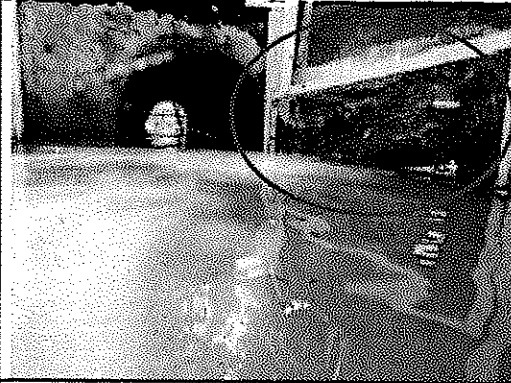
Imagen 7: Reja con malla, la cual posiblemente, imposibilita un flujo constante del agua en momentos de alto caudal.
