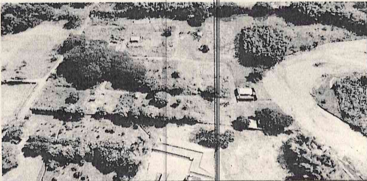
Fotografía 3: Polígono del predio proyecto los Samanes. Se aprecia que el predio se ha parcelado y el río Claro ha vuelto al curso del mismo, por donde discurría antes de la presunta infracción año 2012.
