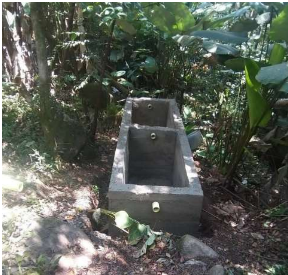
Figura 3. Referencia territorial de una estructura no enterrada en mampostería/concreto; el lecho final permanece abierto y plantado.
