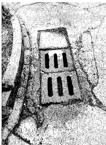
Foto 1. Sumidero para la captación de aguas lluvias localizado en la esquina del restaurante Trifásico.
