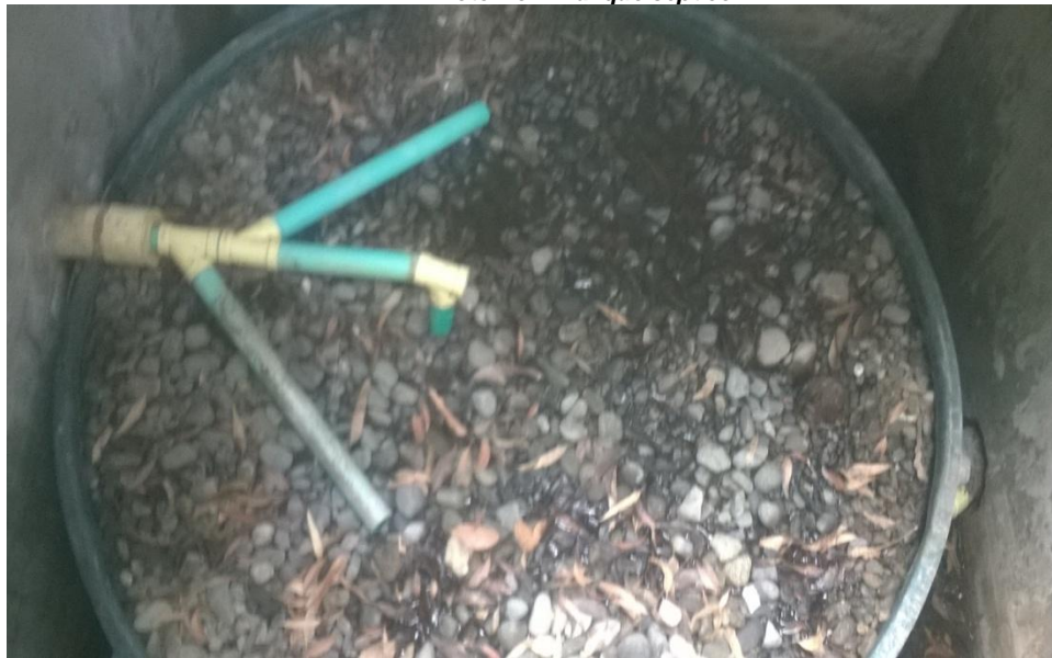
Foto No 3. Filtro anaerobio
