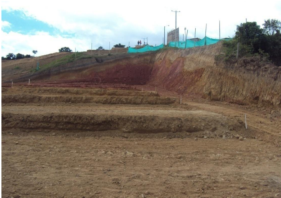
Foto No1. Adecuación del lote para la ubicación de las viviendas de interés social
