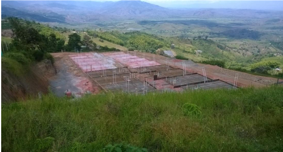
Foto No. 2 Bloques modulares y bases en las primeras viviendas.
