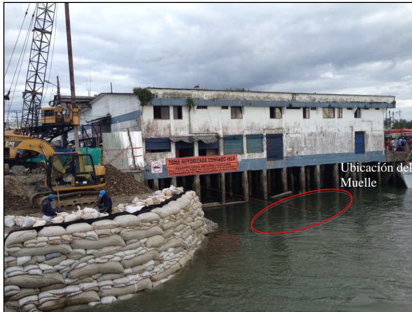
Foto 1. Ubicación de la plataforma lateral al Puente El Piñal.
