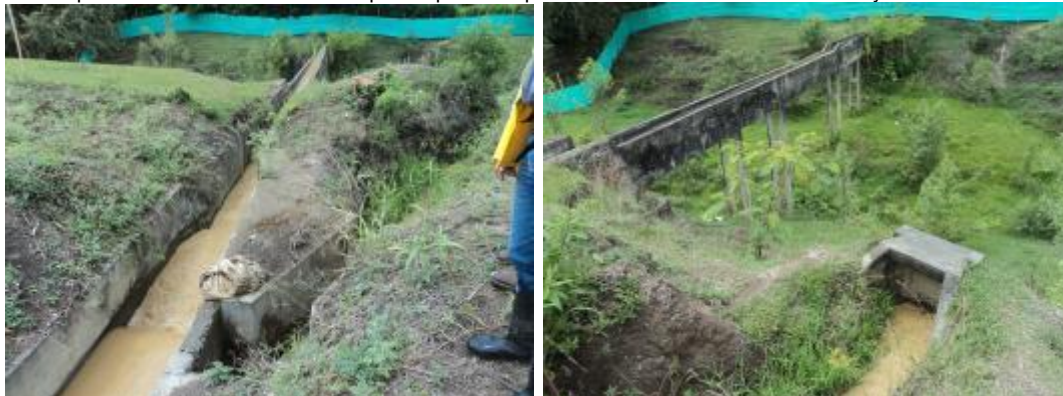
Fotos 3 y 4: Detalle de la obra de derivación a reubicar y de las obras de conducción con las que se deben empalmar las nuevas obras.
