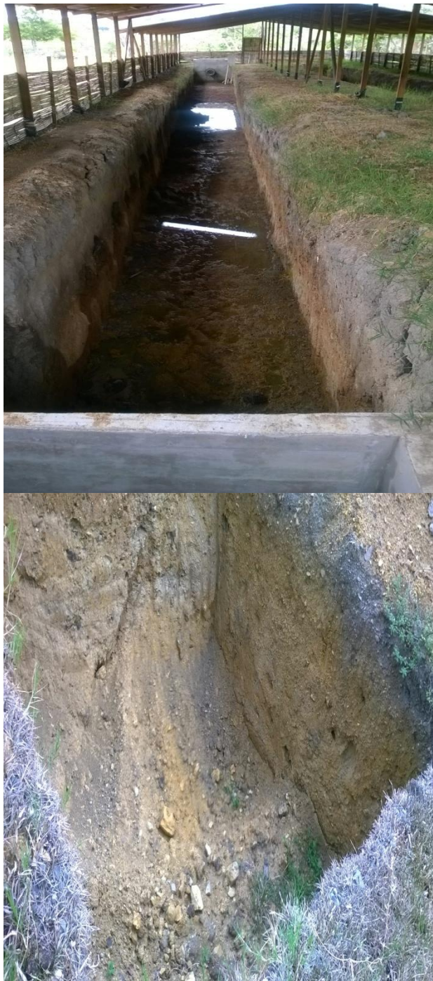
Foto No. 3 Apertura de huecos para la instalación del biodigestor y tanque estercolero
