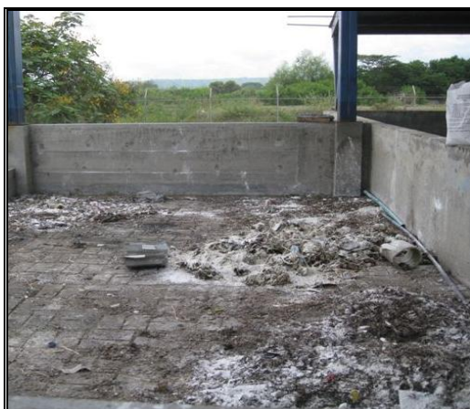
Fotos No. 14 y 15 Celda re residuos sólidos de rejillas y desarenadores.
