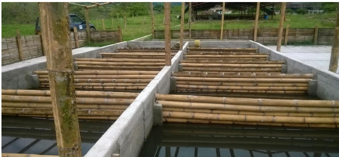
Foto No 2. Sedimentador de alta tasa
