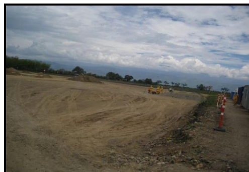
Fotos – Obras construcción de la planta
