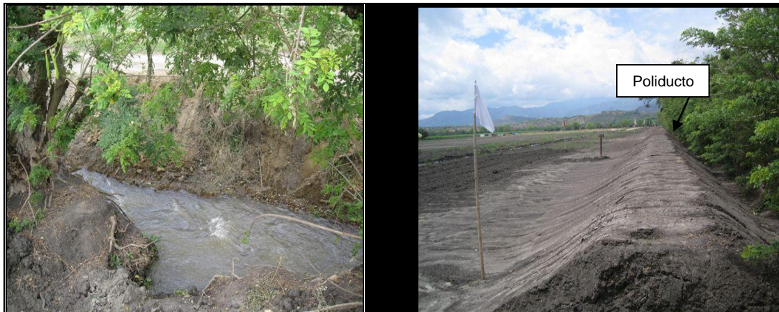
Fotos - Zanjón El Mojón y dique de protección
