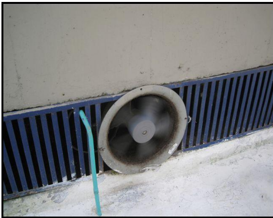
Fotos No. 7 y 8 Ventilación forzada filtro percolador primera etapa
