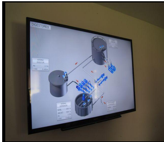
Fotos No. 16 y 17 Sistematización de la PTAR
