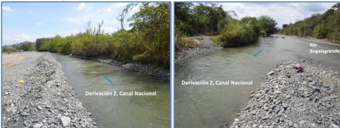
Foto 2. Derivación 2, Canal Nacional
