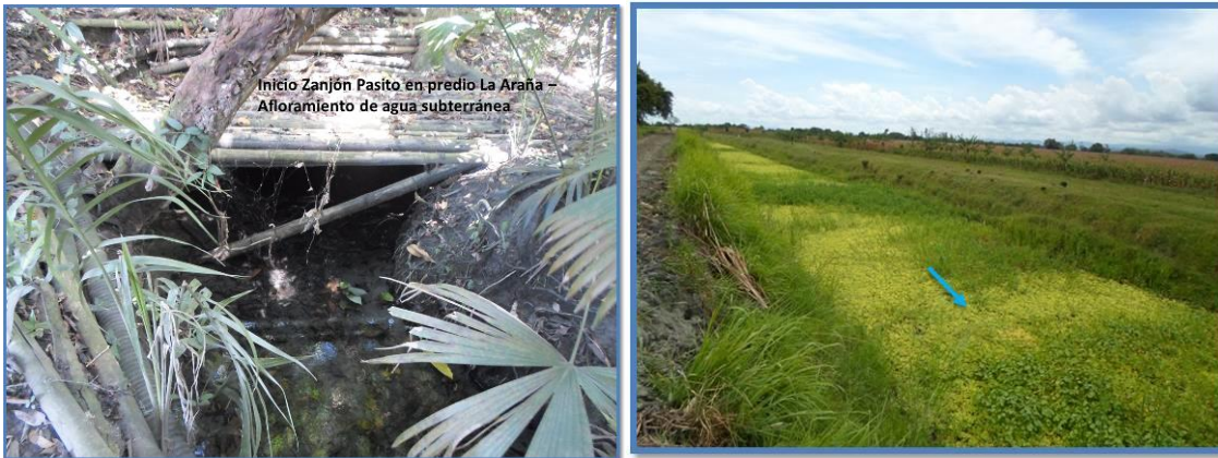
Foto 13. Inicio del Zanjón El pasito en el predio La Araña y vista de su paso por el predio Cecilia
