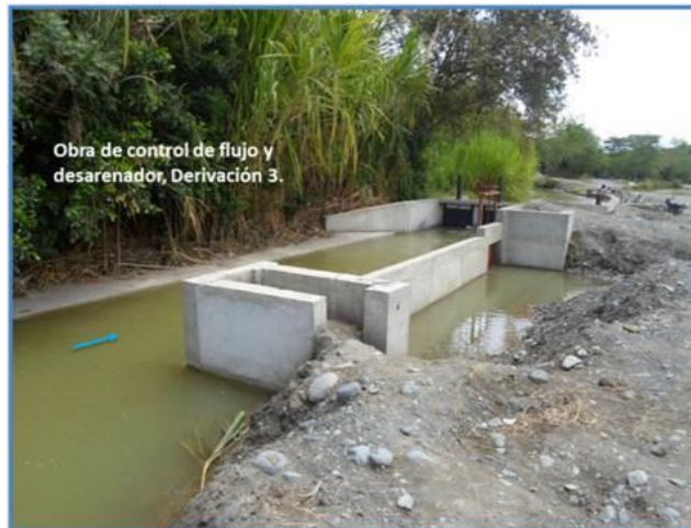
Foto 5. Obra de control de flujo y desarenador en la derivación 3
