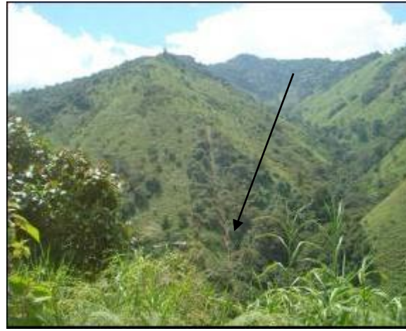
Foto 30: Vista panorámica de longitud del cable aéreo.
