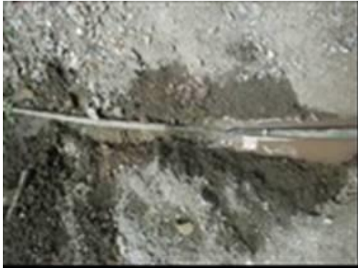
Foto 40: Bocamina La Emilia, Predio La Emilia. Se observa salida de agua.
