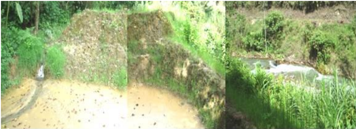
Foto 22. Panorámica de pozos en tierra para sedimentación de arenas (lagunas).
