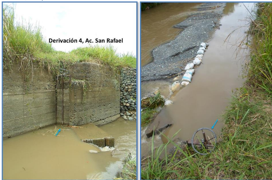
Foto 7. Derivación 4, acequia San Rafael
