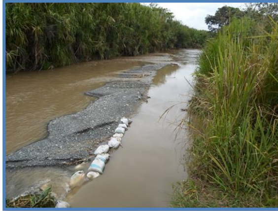
Foto 8. Trincho de derivación de la derivación 4, acequia San Rafael
