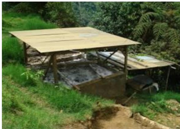
Foto 46: Tanques de cianuración.
