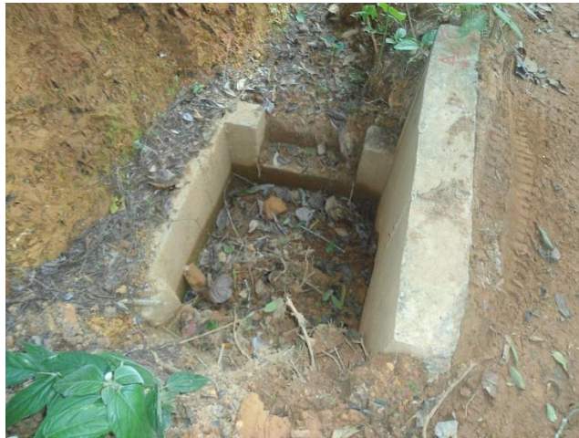
Alcantarilla colmatada
