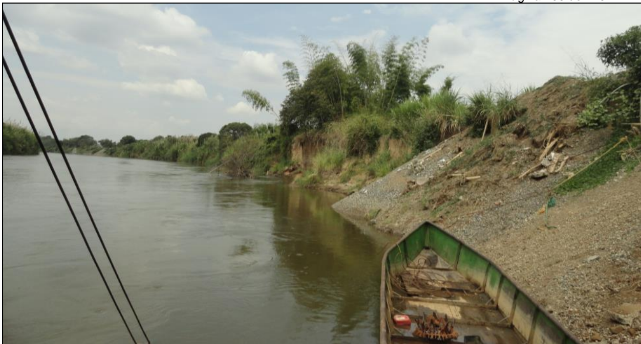
Foto No. 1. Barrancos de la margen izquierda del cauce del río Cauca, junto al sitio de la Draga No. 2 de la Arenera. Se observa el arroj de escombros, con la intención de frenar la erosión marginal.
