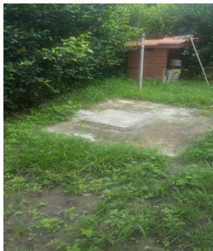
Foto No 3 campo de infiltración
