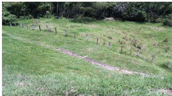
Foto 5. En este registro se puede observar el área donde se construyó el campo de infiltración que recibe el efluente del filtro anaerobio
