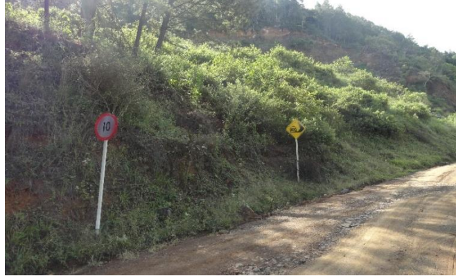
Figura 6: cunetas laterales de las vías de acceso.
