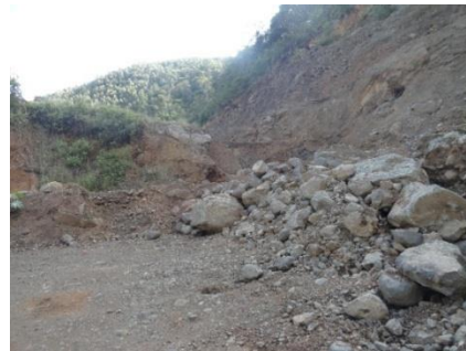
Figura 3: roca demolida parte baja.
