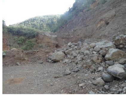
Figura 3: roca demolida parte baja.
