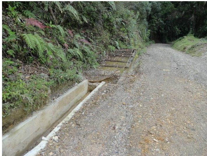
Figura 6: canal en concreto y tanque desarenador, el rebose se conduce al canal de la vía.
