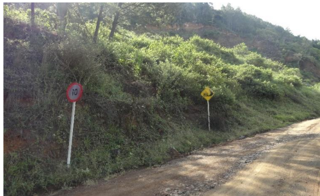
Figura 6: cunetas laterales de las vías de acceso.
