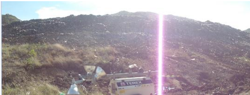
Foto No. 1 Actual frente de operación sin la cobertura y compactación diaria requerida
