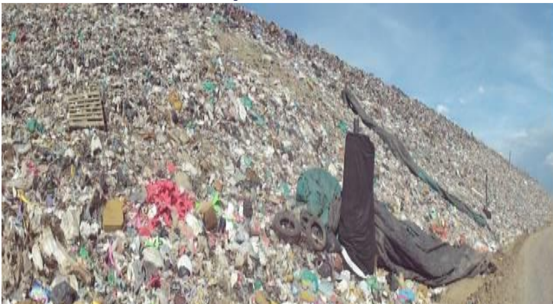
Foto No. 3 Zona noroccidental del vaso C2T2 sin cobertura
