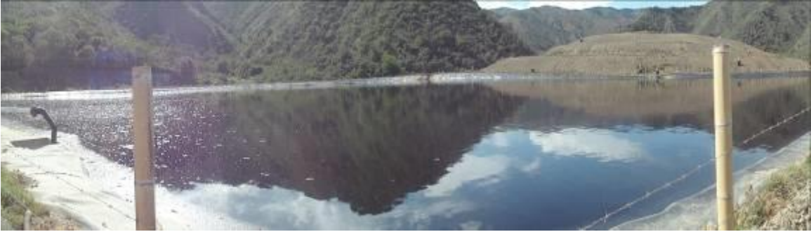
Foto No. 6 Laguna de homogenización poco borde libre
