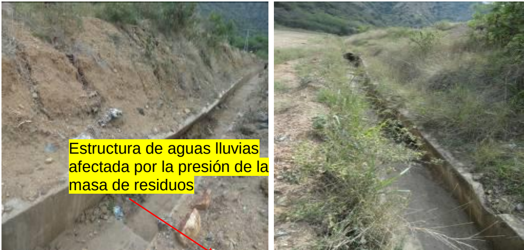
Foto No. 5 estructura del canal de aguas lluvias fracturadas.
