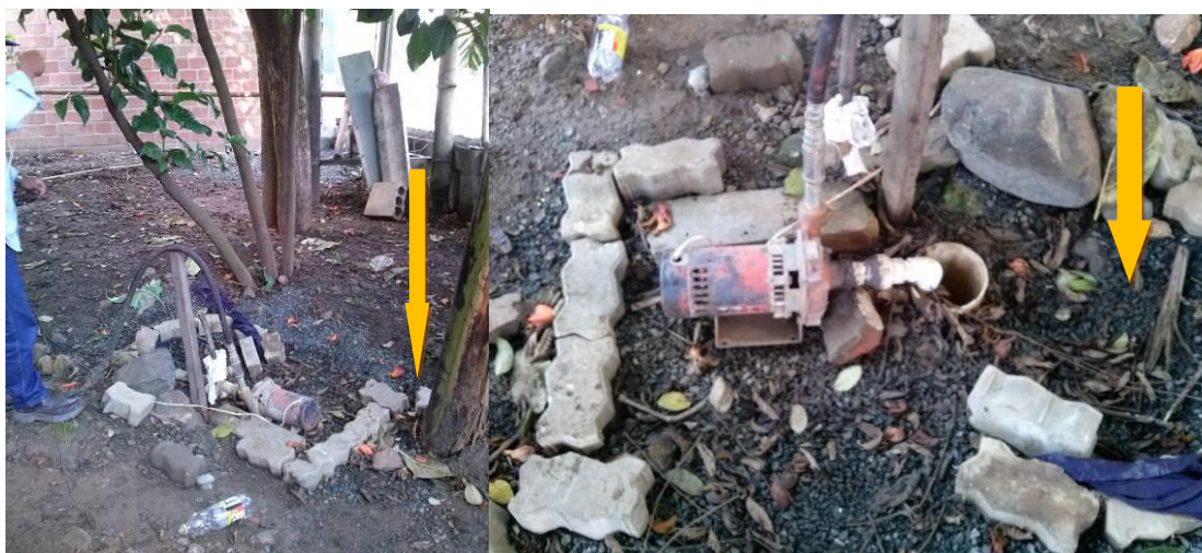
Foto 1. Estado del pozo.
