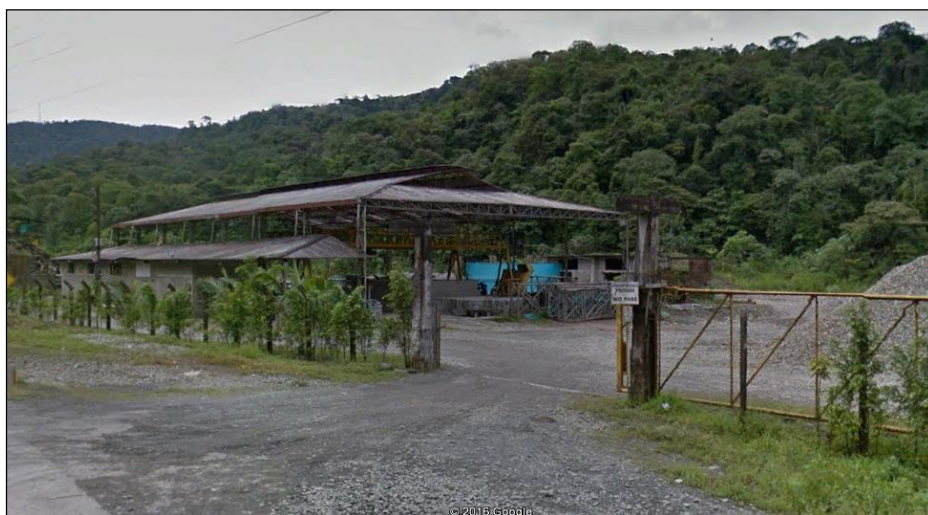
Fotografía No. 2. Patios de almacenamiento
