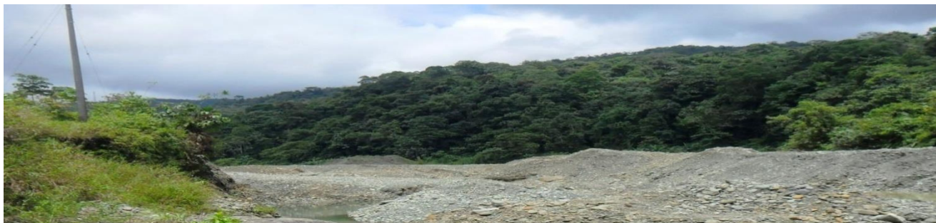
Fotografía. No. 3. Se observan los grandes volúmenes de material aluvial dentro del cauce del río Dagua.
