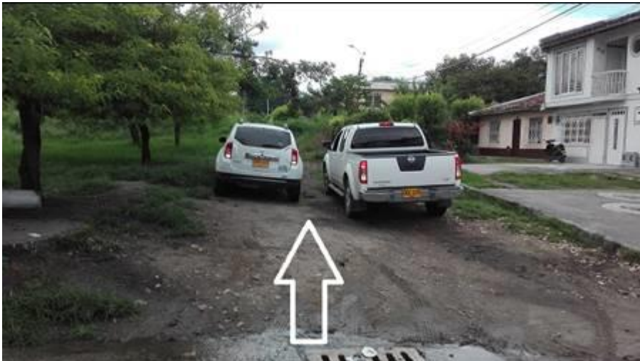
Foto 1: en la foto se observa el estado actual de la calle 22 en dirección hacia quebrada La Honda.
