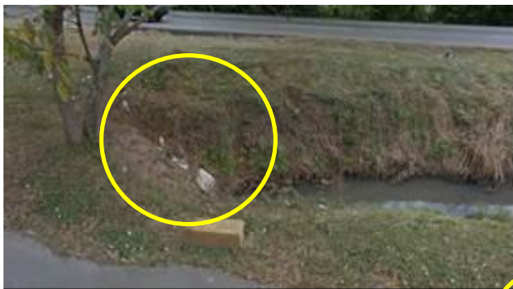
Paso del Agua del canal que va por debajo de la doble calzada hacia el predio La Chepa
