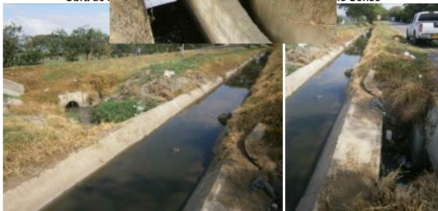
Cruce de aguas residuales y sobrantes de agua de la derivación 5, Acequia San Rafael del Rio Sonso
