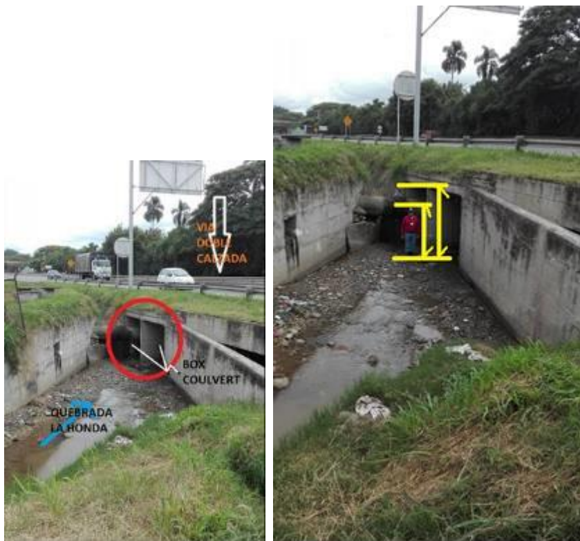
Fotos 4 y 5: Detalles fotográficos del estado del cruce de la quebrada La Honda bajo vía doble calzada Buga – Tuluá.
