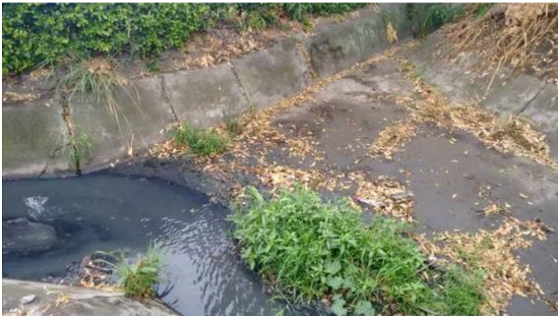
Canal después del paso de la doble calzada, antes de la obra de captación del predio La chepa
