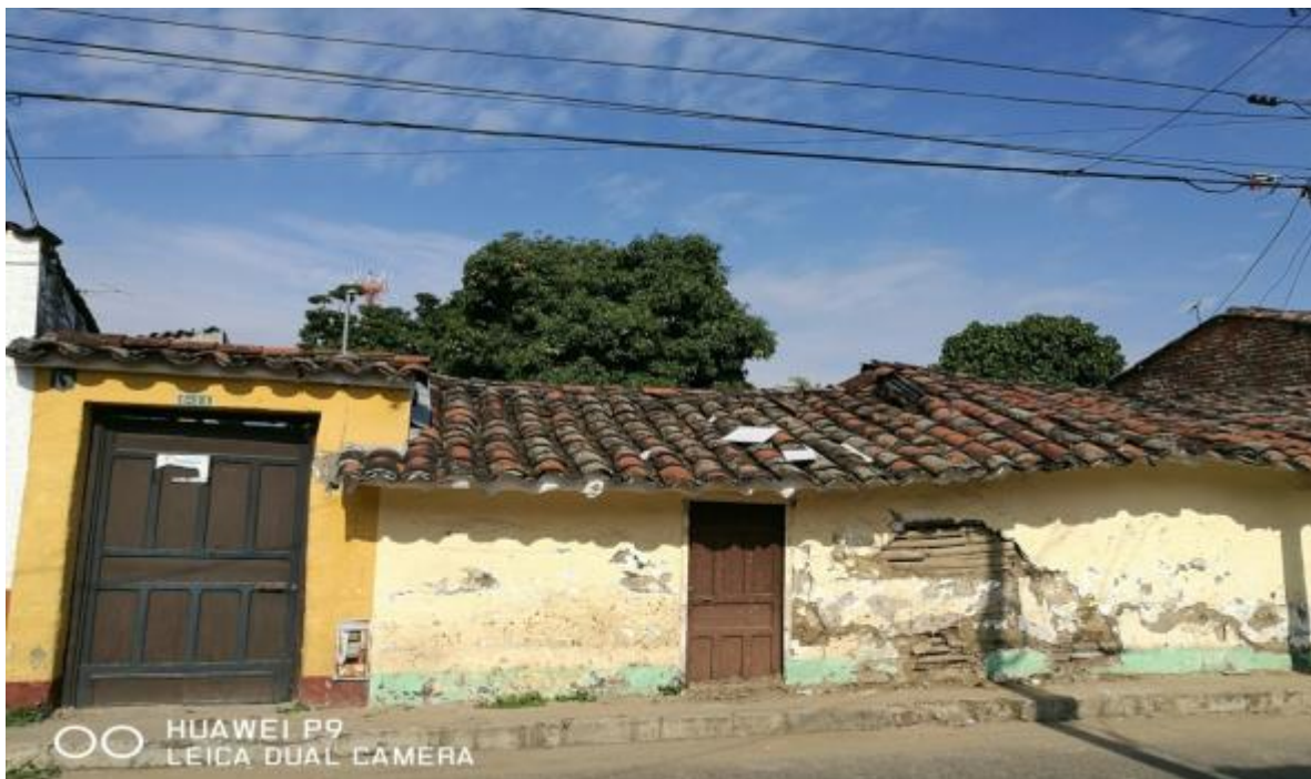
Registro fotográfico de la vivienda carrera 5 No 6-31
