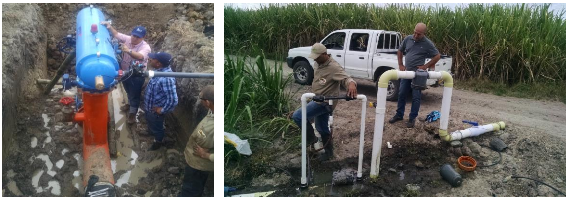
Imagen 1. Instalación filtros sistema riego por goteo
