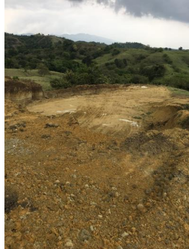
Foto 6: segundo frente de explotación y que está dentro del área del contrato de concesión.
