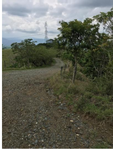
Foto 8: arreglo de la vía interna de mina que comunica al frente de explotación.
