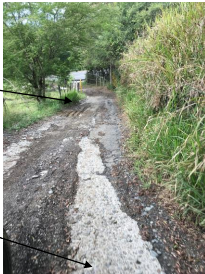
Foto 7: construcción de placas huellas para acceso a la mina y evitar desplazamiento de material a la vía principal
