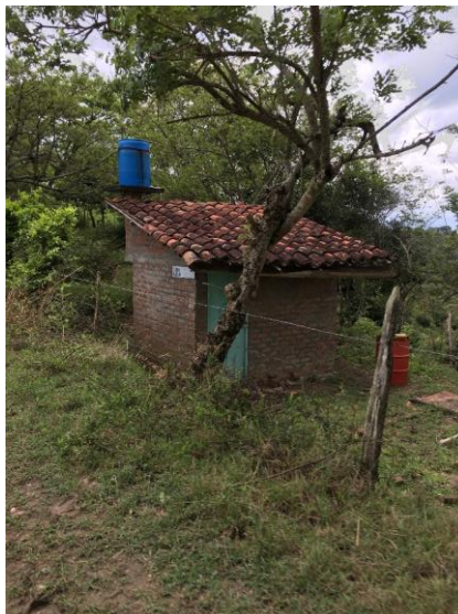
Foto 9: unidad sanitaria construida con tanque de almacenamiento de agua lluvia para su funcionamiento
