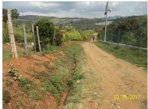
Foto 6. Cunetas para el manejo de agua lluvias.
