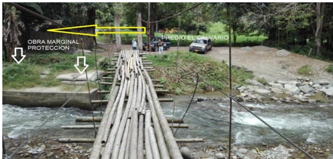
Foto 12: Detalle de la ubicación de lindero del predio El Calvario, las obras de fijación de orilla y el estado actual del río Guadalajara en el sector.
