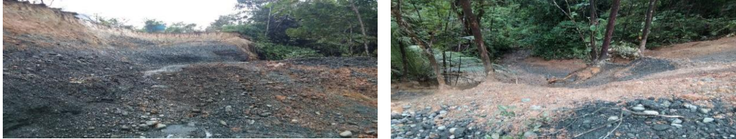
Imágenes 1-2 daños ambientales evidenciados
