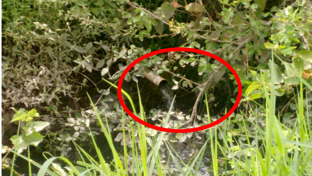
Foto 2. Entrega de Aguas del predio Hato Canadá a la zanja construida en el Predio La Miel
