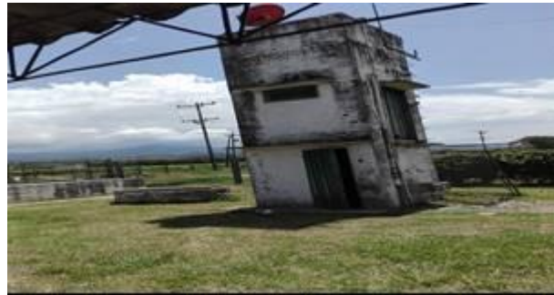
QUINTO POZO SIN TRÁMITE UBICADO EN TALLERES O PORTERIA PRINCIPAL
