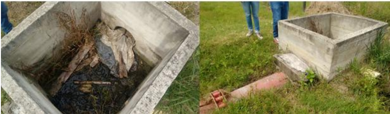
Foto 3. Obra Hidráulica (Cámara de reparto)
