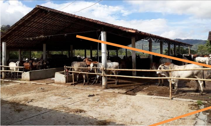
Estructura convencional donde se está ejecutando la actividad de explotación Ganadera
