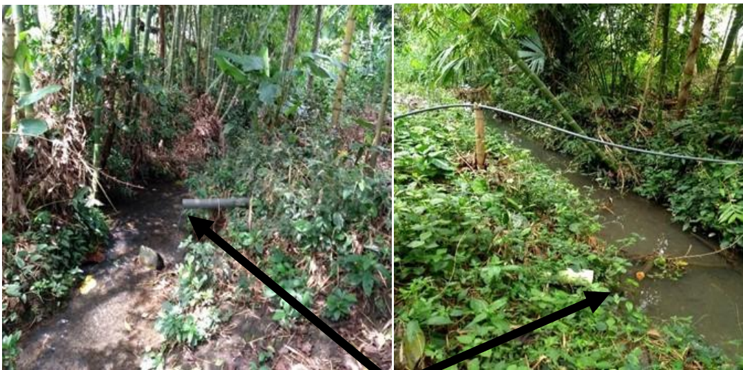
Puntos de vertimiento de las cocheras a la quebrada las Iracas.
