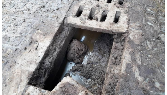
Canales de aguas lluvias perimetrales en el corral, que drenan el producto de la explotación ganadera.
