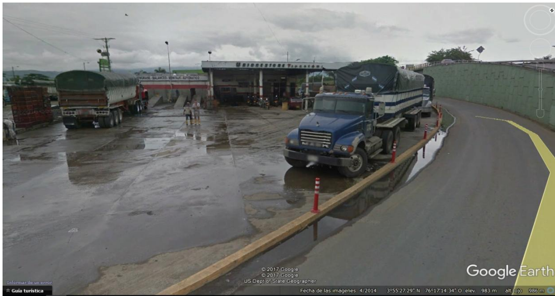
Imagen No. 2. Se observa el flujo de aguas de lavado de tracto camiones discurriendo por fuera del perímetro del predio. Fuente Google Earth
