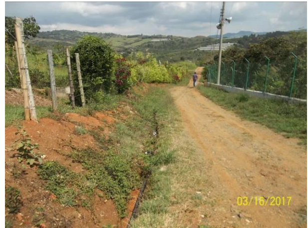
Foto 6. Cunetas para el manejo de agua lluvias.
