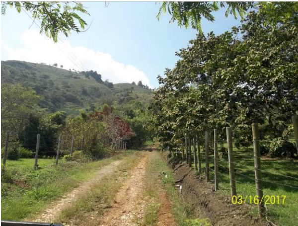
Foto 5. Estado de las vías internas.
