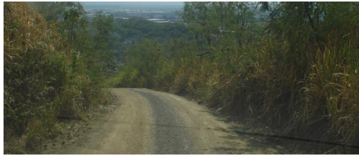
Foto8: vía de acceso al frente con canal de aguas lluvia y sin proceso de mantenimiento.
