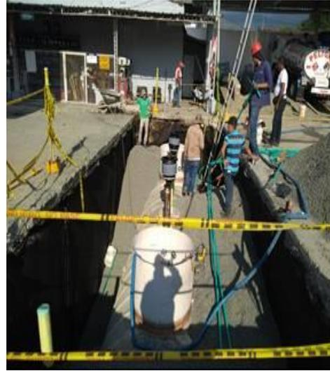
Foto 2. Tanque en proceso de instalación.
