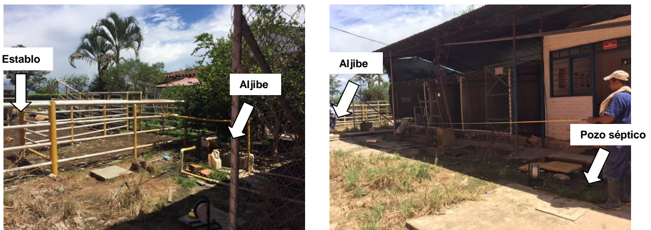
Fotografías 1 y 2. Ubicación del aljibe, establo y pozo séptico
