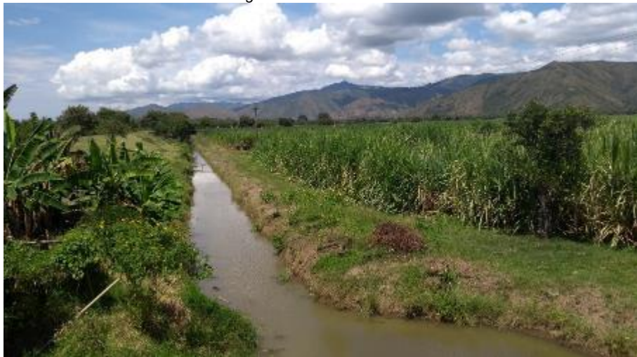
Figura 3. Canal colector para el bombeo de aguas lluvias del sector.
