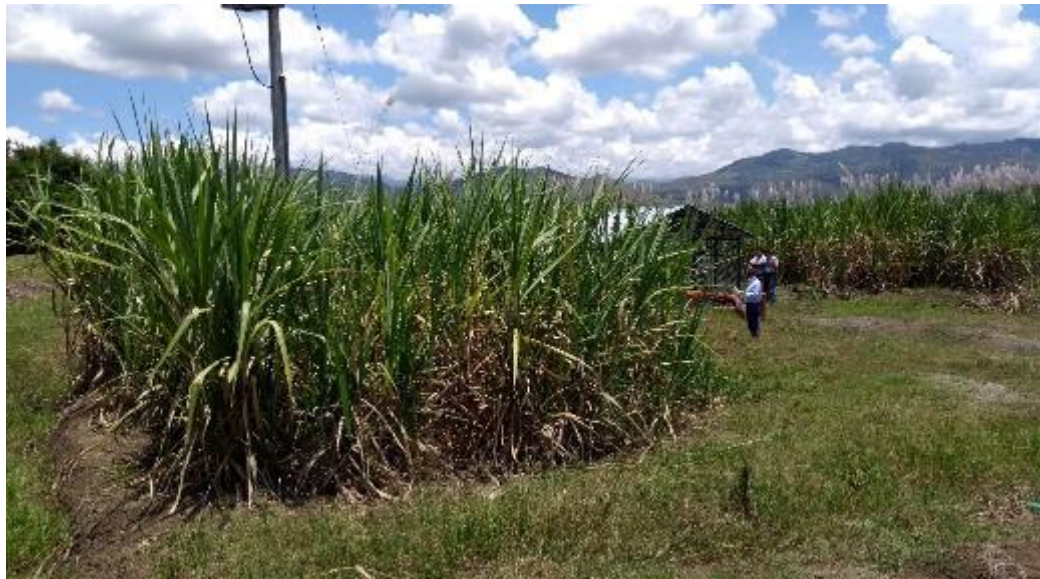
Figura 5. Estación de Bombeo, para el proyecto Zona Franca.
