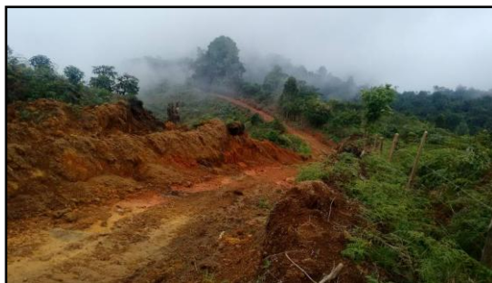
Foto 1. Estado actual de la vía que ampliaron
