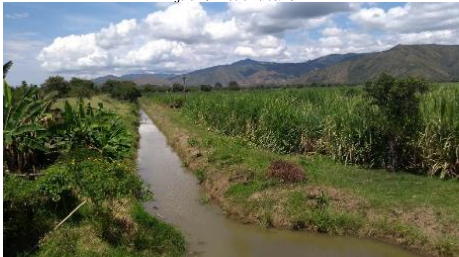
Figura 16. Canal colector para el bombeo de aguas lluvias del sector.
