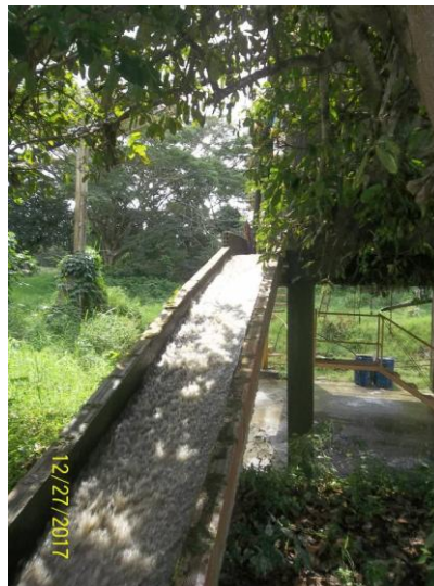
Foto No. 6. Canal que evacúa las aguas del tanque elevado.
