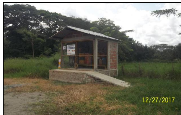
Foto No. 8. Caseta de almacenamiento de combustibles.
