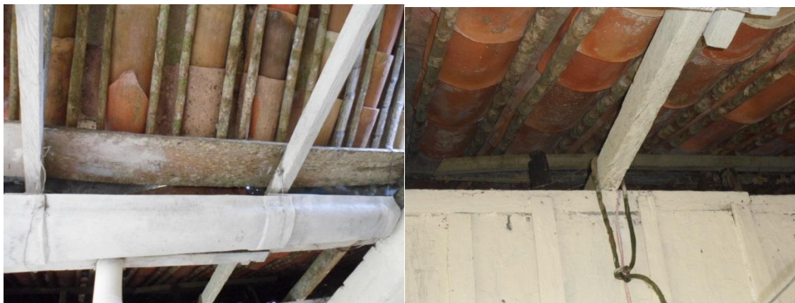
FOTOS 19 y 20. ASPECTOS CONSTRUCTIVOS DE CASA HABITACIÓN (VIVIENDA) DEL PREDIO "JUICIO FINAL". TECHO.
