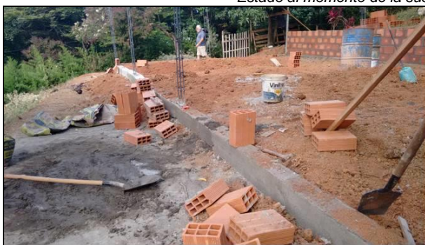
Fotos: Huecos donde se fundirán columnas por construcción de vivienda – Junio 23 de 2016
