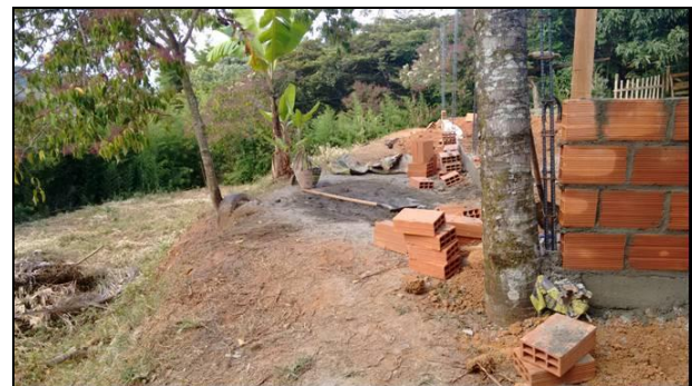
Fotos: Huecos donde se fundirán columnas para construcción de vivienda – Junio 23 de 2016
