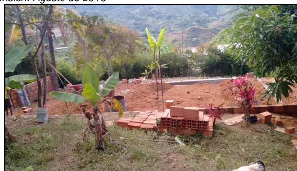
Fotos: Huecos donde se fundirán columnas por construcción de vivienda – Junio 23 de 2016
