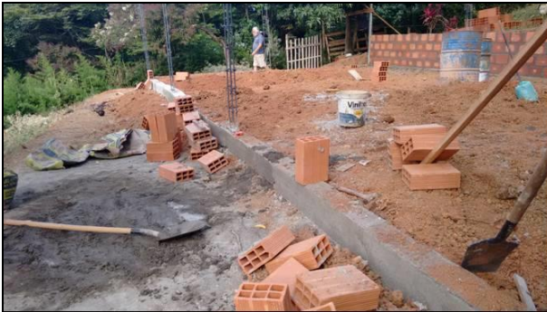
Fotos: Huecos donde se fundirán columnas para construcción de vivienda – Junio 23 de 2016
