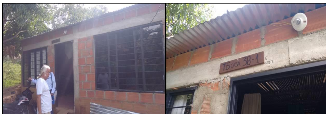
Estado al momento de la visita del predio Enero de 2017
