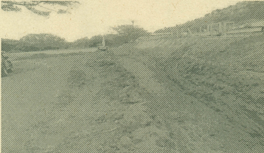
Foto No. 3 Para la adecuación el terreno mediante excavación, sólo falta el 10% aproximadamente
