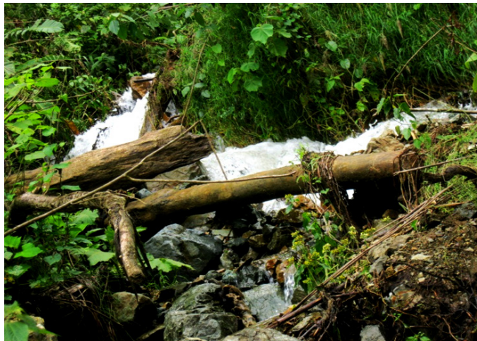
Foto 8. Empalizada en la quebrada Pajonales
