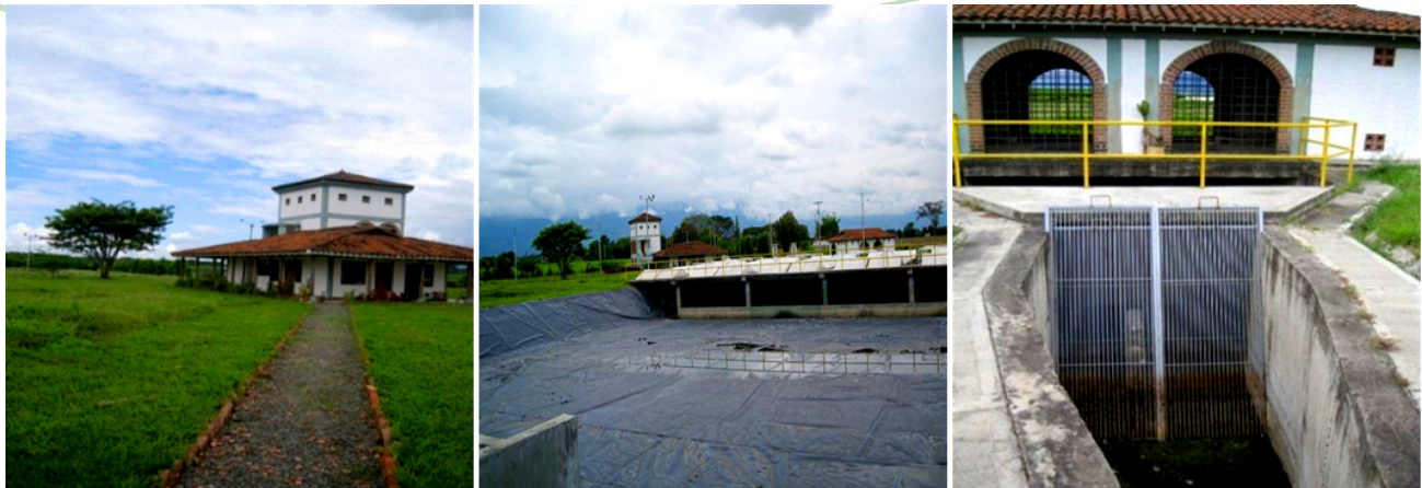
Foto 9. Planta de Tratamiento de Aguas Residuales
