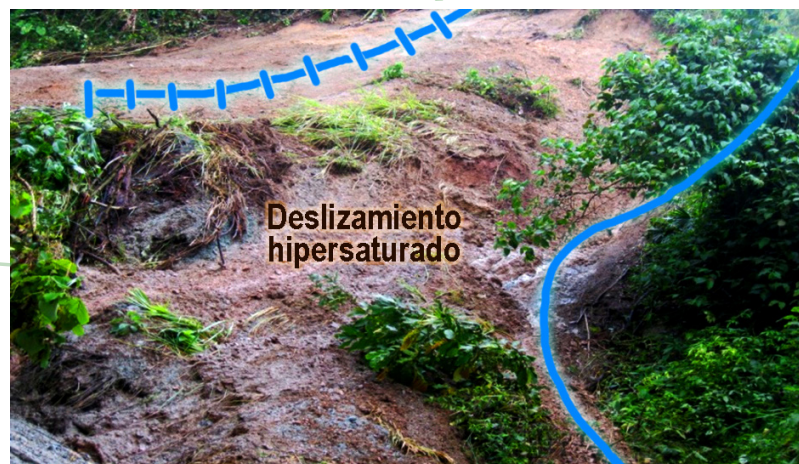
Foto 1. Obstrucción de la quebrada Los Cuchos
